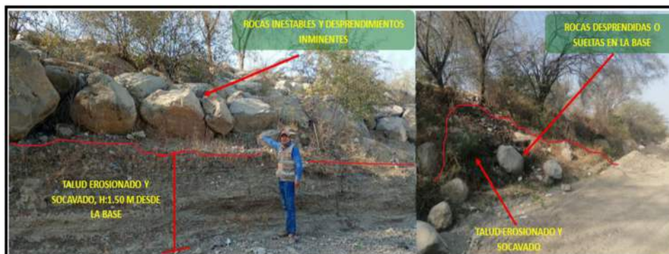
FIGURA 03: PROCESO DE DESESTABILIZACIÓN DEL TALUD DEL DIQUE EN EL SECTOR PLAYA DE CASCAJAL. LA IMAGEN MUESTRA EL ESTADO CRÍTICO DEL DIQUE, DONDE LA EROSIÓN FLUVIAL HA INICIADO UN PROCESO DE DESESTABILIZACIÓN DEL TALUD, INCREMENTANDO LA VULNERABILIDAD DE LA ESTRUCTURA. ESTA SITUACIÓN LO HACE PROPENSO A UNA FALLA, LO QUE PODRÍA RESULTAR EN UNA INUNDACIÓN Y AFECTACIÓN DEL CASERÍO.
