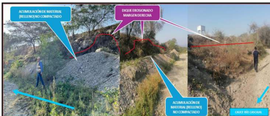
FIGURA 02: TRAMO CRÍTICO DEL RÍO CASCAJAL EN EL SECTOR PLAYA DE CASCAJAL, QUE MUESTRA LA EROSIÓN DEL DIQUE. LA IMAGEN ILUSTRAS LAS ACCIONES DE LA COMUNIDAD QUE INTENTA DETENER EL AVANCE DEL DAÑO AL DIQUE CON MATERIAL NO COMPACTO, UNA SOLUCIÓN TEMPORAL Y VULNERABLE.
